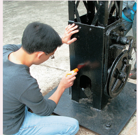
▲ 我們完成修復處理後，量度油漆的乾膜厚度
