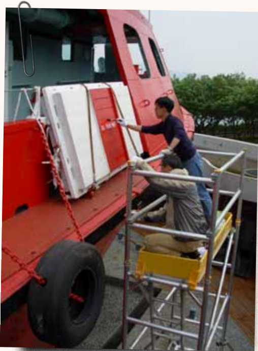
▲ 為葛量洪號滅火輪進行檢查及修復工作
