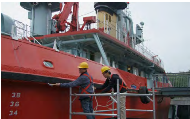
▲ 修復人員正在清理「葛量洪號滅火輪」的銹蝕
